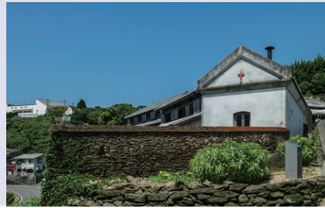
マカロニ工場全景。手前に見える「ド・ロ壁」は、赤土に石灰を混ぜたものを接合材として用いて、地域で産出される岩を積み上げた丈夫な壁で、これもド・ロ神父が伝えたもの。
