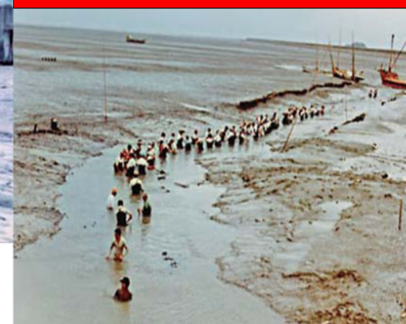
堆積したガタ土を人力で除去していた
