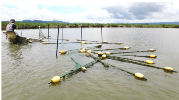
図 9 2020年7月6日に発生した豪雨災害後、7月22日の進出工内の波浪軽減施設(水平張り)の状況
