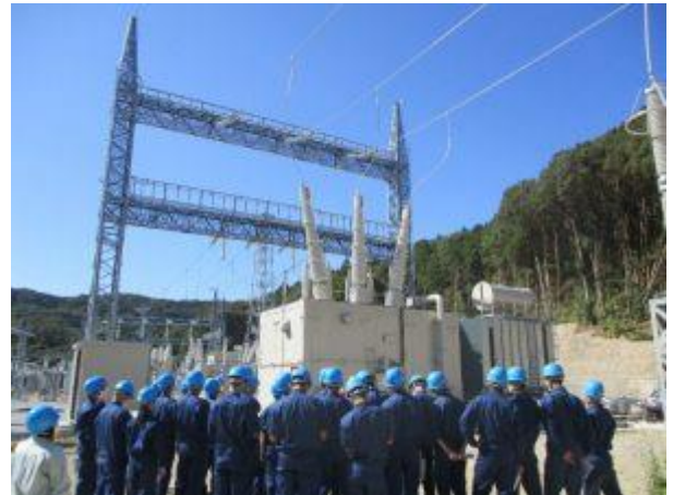
【新諫早変電所での見学の様子】
