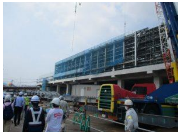
【駅舎建築工事の見学の様子】
