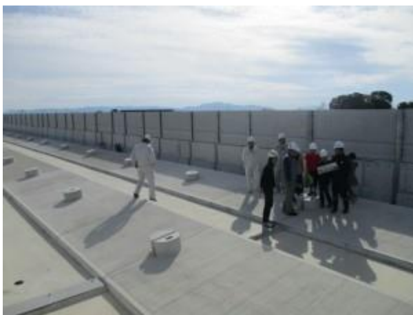
【見学の様子(竹松高架橋上)】
