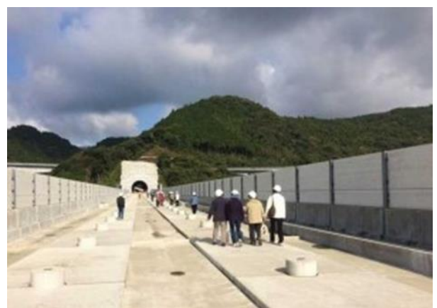
【千綿川橋りょう現場見学会状況】
