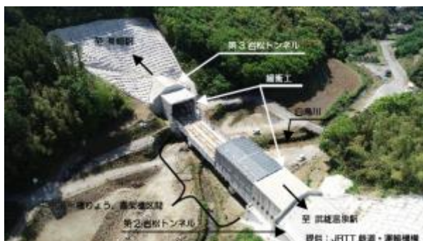
白鳥川付近(第2岩松トンネル・第3岩松トンネル間)
