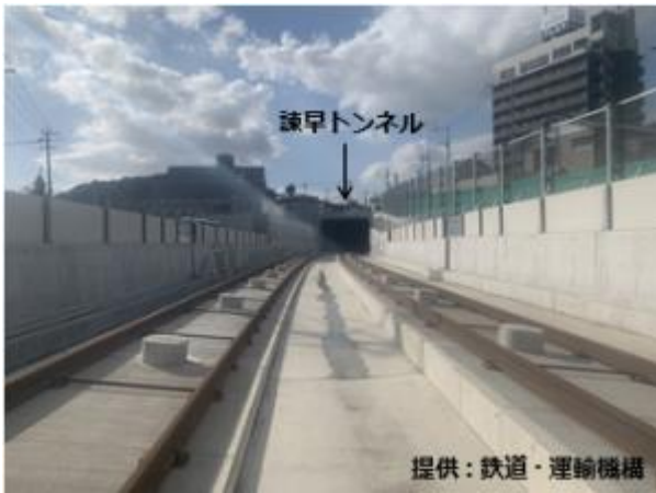
【完成した諫早トンネル (諫早駅方から長崎駅方を望む)】
