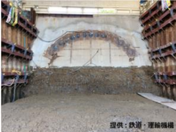
【パイプルーフ施工完了状況(H30.8撮影)】
