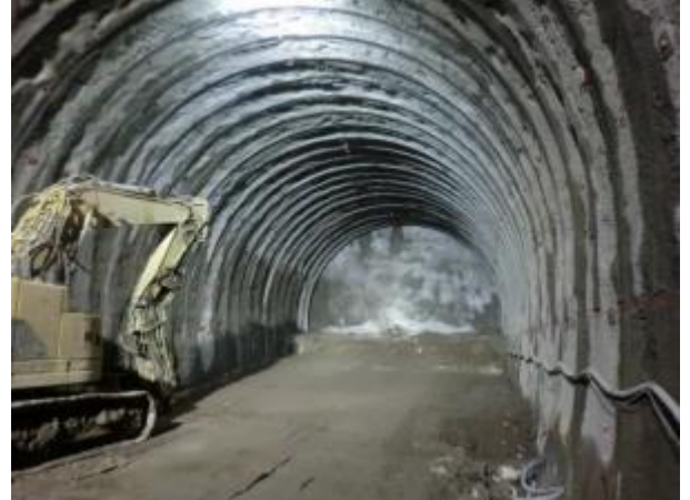
【トンネル掘削状況(H30.11撮影)】
