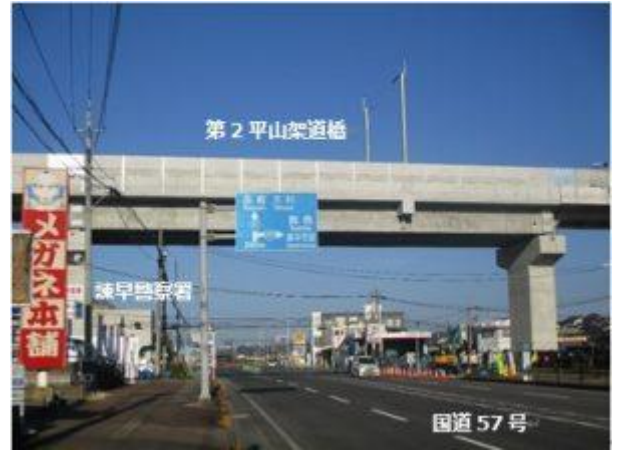
【完成した第2平山架道橋(小船越町)】
