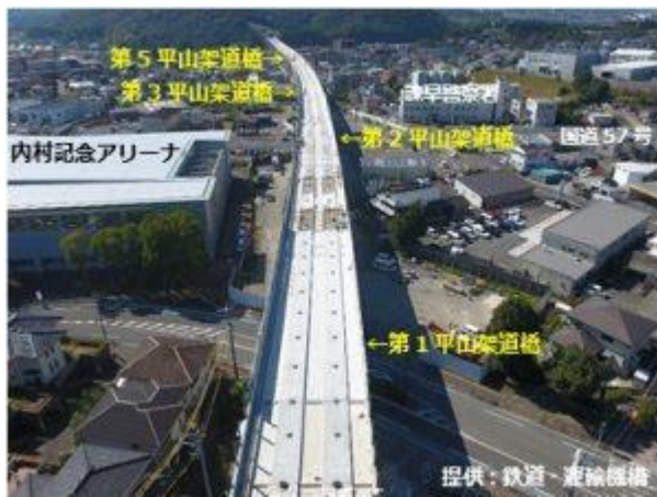
【宇都町から平山町にかけて完成した橋りょう】
