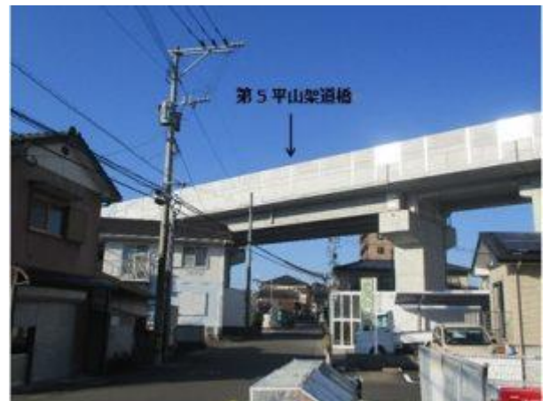
【完成した第5平山架道橋(平山町)】
