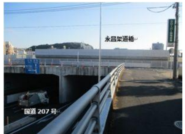
【完成した永昌架道橋(永昌町)】
