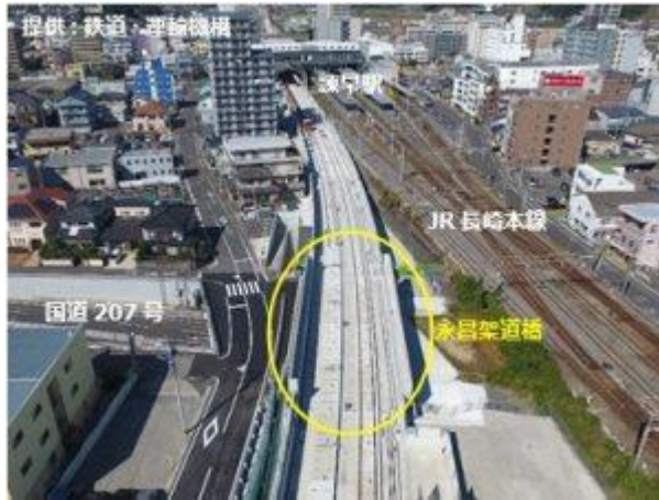
【完成した永昌架道橋(永昌町)】
