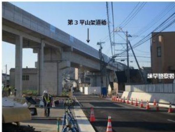
【完成した第3平山架道橋(小船越町)】
