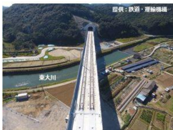
【完成した東大川橋りょう(平山町)】
