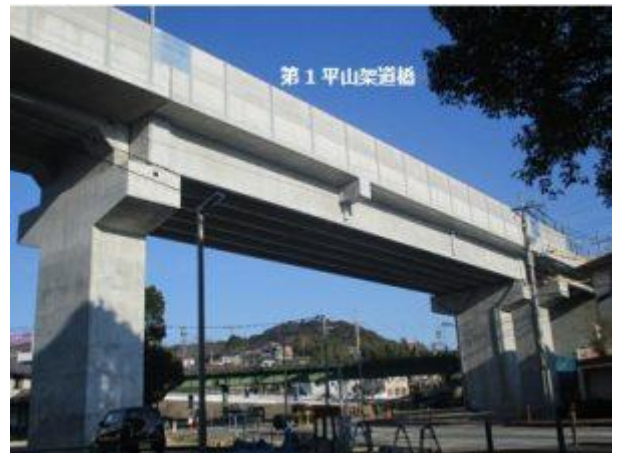
【完成した第1平山架道橋 (宇都町から小船越町)】
