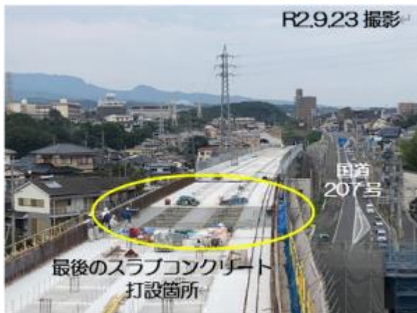
【スラブコンクリート打設完了状況】
