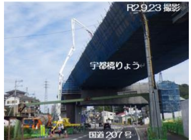
【スラブコンクリート打設状況】
