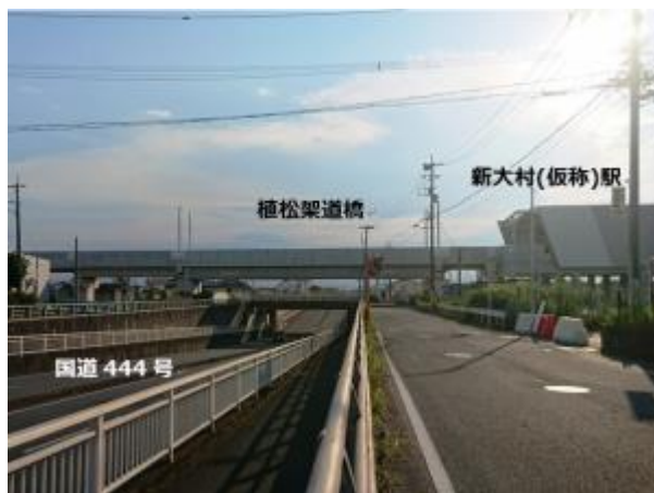
【完成した植松架道橋】
