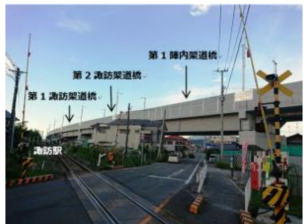
【完成した第 1 諏訪架道橋、第 2 諏訪架道橋、第 1 陣内架道橋】
