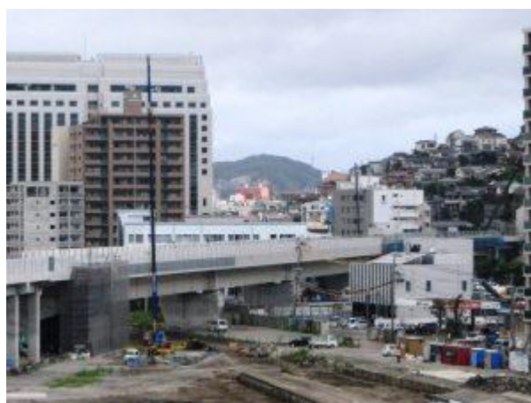
【完成した八千代 Bi(八千代線路橋)】
