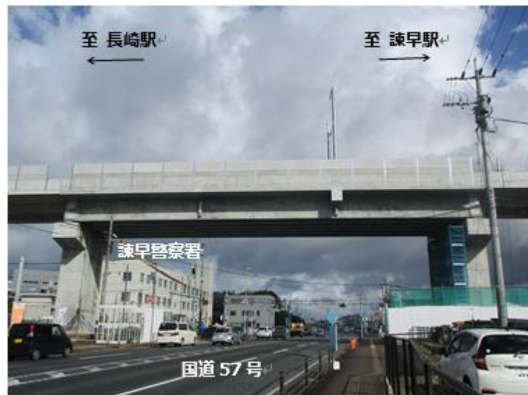
完成した「第 2 平山架道橋」(R2.7.20 撮影)
