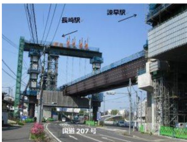
【架設完了 (R2.4.27 撮影)】
