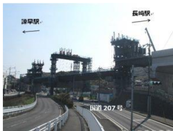
【架設完了 (R2.4.27 撮影)】
