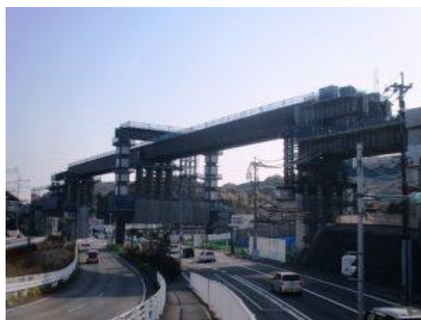
【送り出し架設後、降下作業開始前 (R2.3.18 撮影)】
