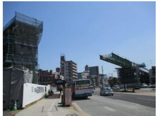
【架設状況(R2.4.14 撮影)】
