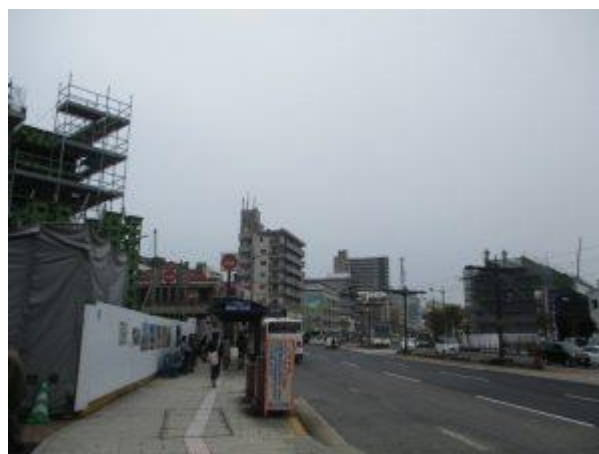
【架設状況(R2.3.31 撮影)】
