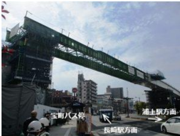
【架設状況(R2.4.15 撮影)】
