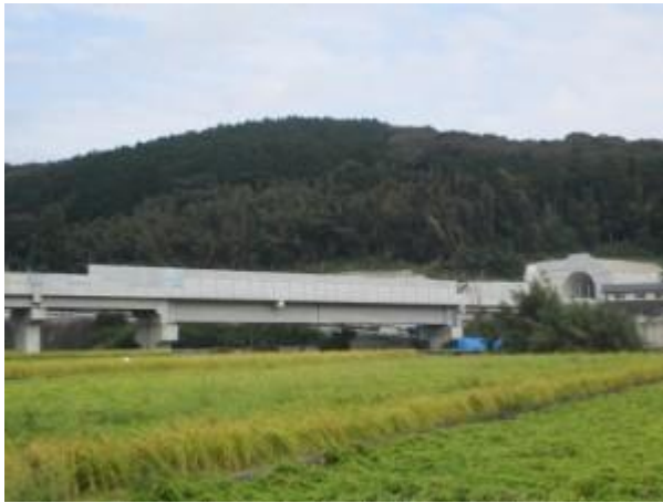
【完成した第 1 本明川橋りょう】
