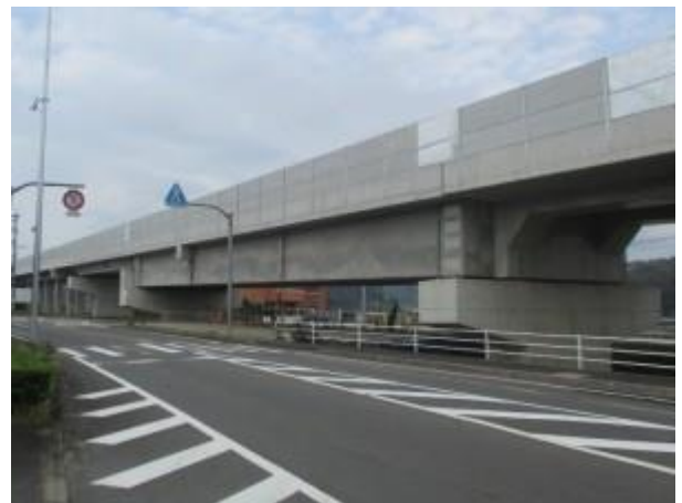
【完成した第 1 本明川橋りょう】
