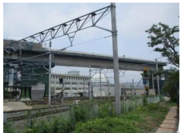
【送り出し架設後】
