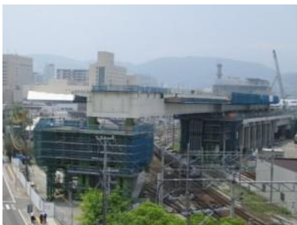
【送り出し架設後】
