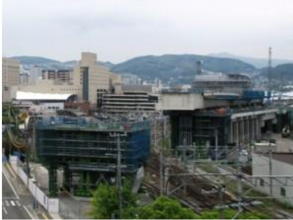
【送り出し架設前】
