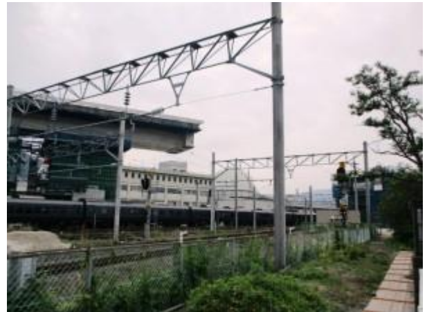
【送り出し架設前】
