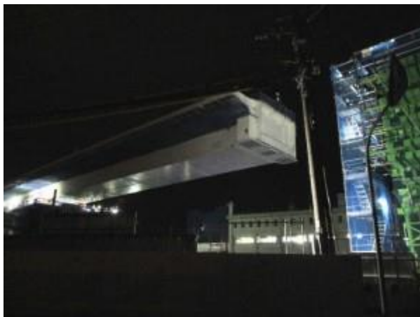
【送り出し架設中】
