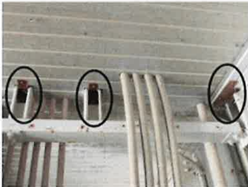
図2 廃材を用いたネズミ侵入防止対策の状況
