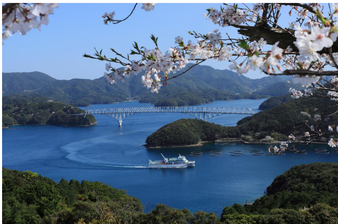
若松大橋(新上五島町)
