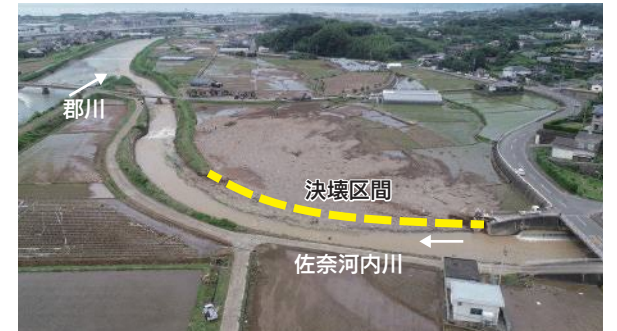
令和2年7月豪雨による佐奈河内川周辺の浸水状況【大村市】
