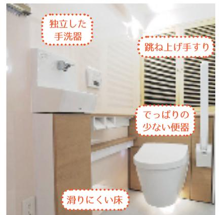
自宅をバリアフリーにする方法には、段差の解消・手すりの取付け・引き戸への変更・出入口や通路幅の拡張などの方法があります。夜間の転倒防止には、廊下や玄関などへの足元灯の設置も効果的です。
