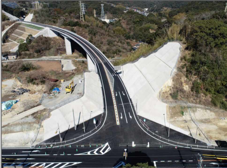
(ICT活用や舗装端部の仕上げの工夫により、走行性が向上するとともに美観に優れた舗装を構築。)
