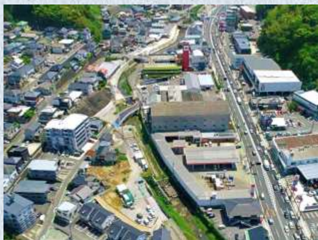
時津川河川改修工事
