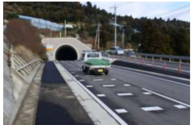
平成29年2月に供用開始した茂木工区
