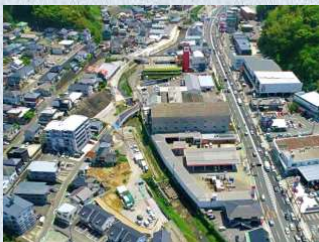
時津川河川改修工事
