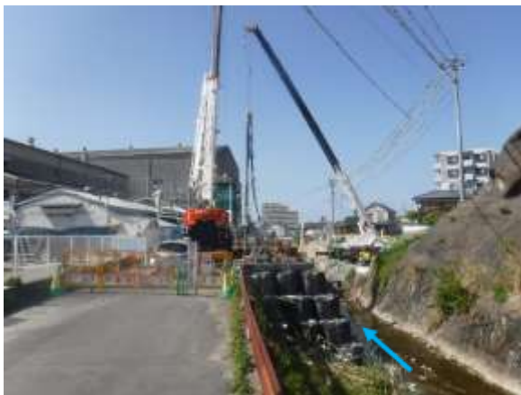
令和4年度施工（護岸工・法面工）
