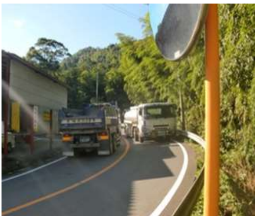
大型車の離合困難状況
