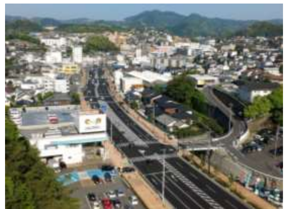
横道工区の供用状況
