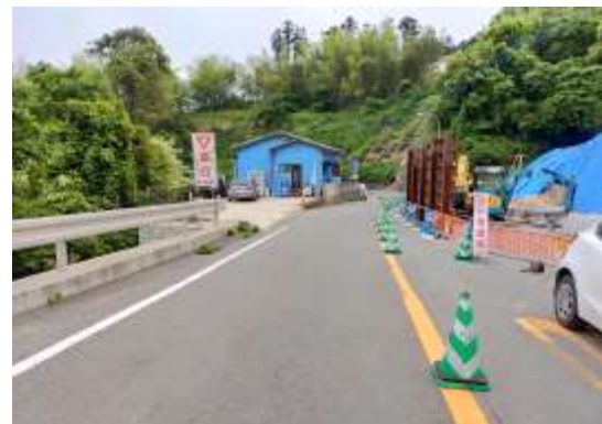
工事の状況（起点側）
