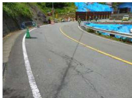
工事の状況（終点側）
