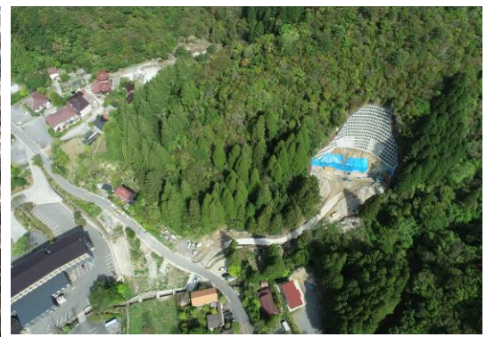
土石流災害復旧工事状況 R5.4 月( 雲仙市 )
