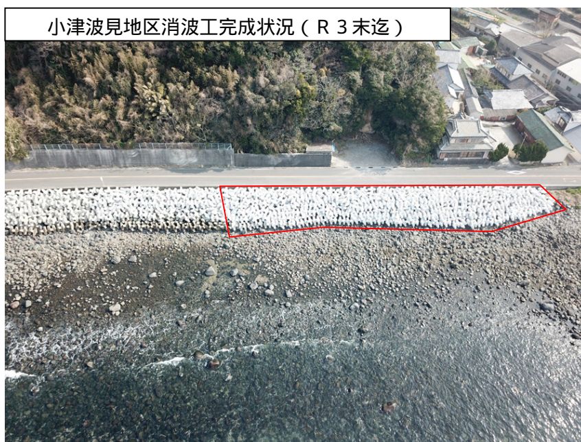
R 3 施工箇所
