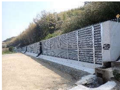
治山工事実施箇所（西海市）
