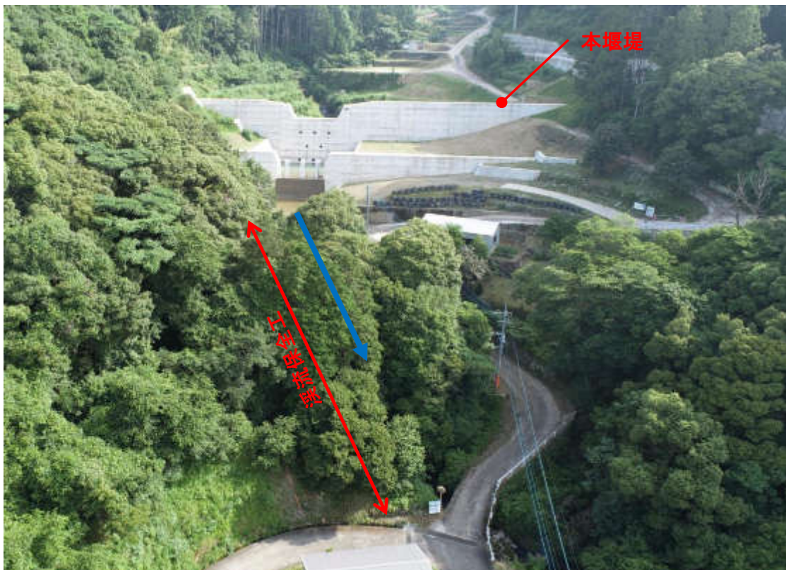
山口谷川砂防施工状況
