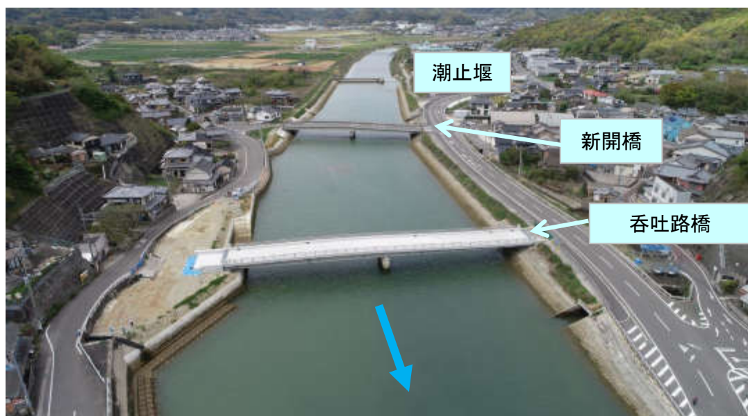
江ノ浦川河川改修工事（施工状況）
