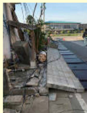
熊本地震での被災事例
