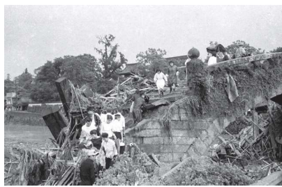
諫早大水害 (S32.7.25) の被災状況
