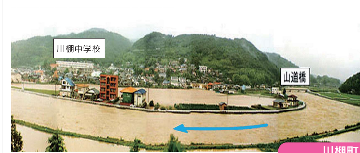
平成2年水害 (H2.7.2) の被災状況
