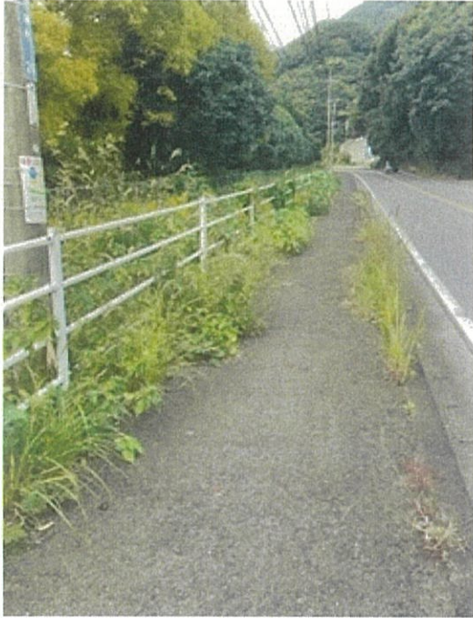
8. 主要地方道 長崎畝刈線清掃状況（清掃前）
