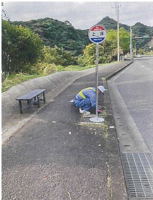
4. 上床バス停付近清掃状況（清掃中）
