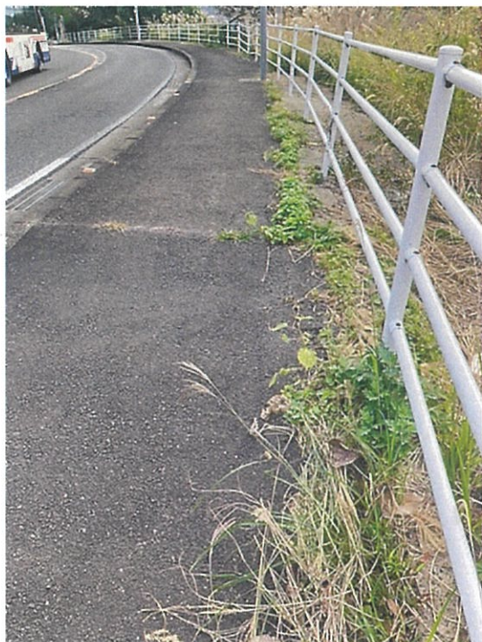
12. 主要地方道 長崎畝刈線路側帯（清掃中）
