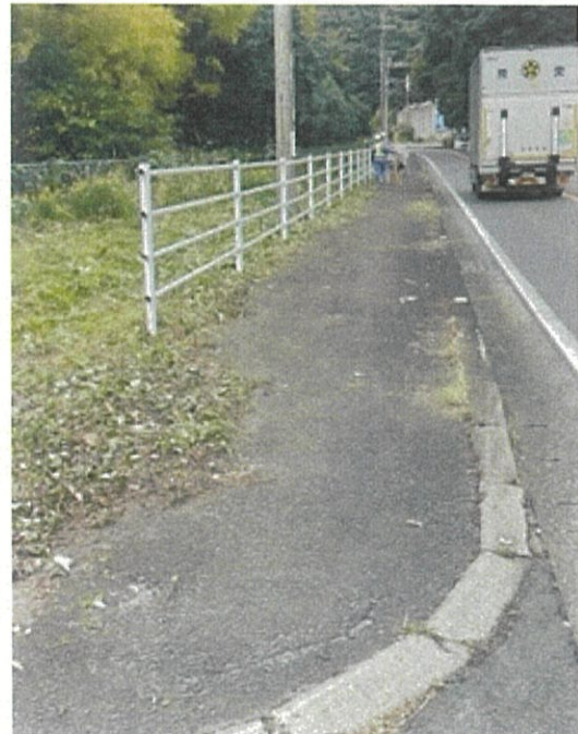
11. 主要地方道 長崎畝刈線路側帯（清掃後）
