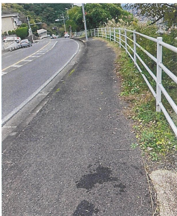
13. 主要地方道 長崎畝刈線路側帯（清掃後）
