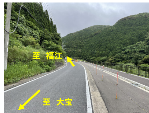
起点側 歩道整備状況
