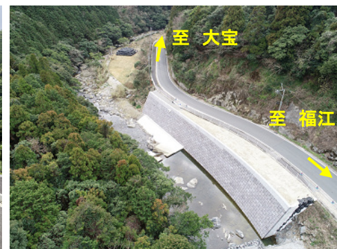
終点側 護岸ブロック積工整備状況
