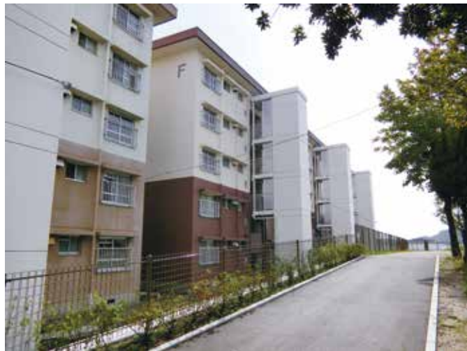
階段室型エレベーターの設置
