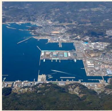
長崎漁港 (提供:長崎港湾漁港事務所)
