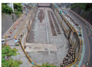
三菱長崎造船所 第三船渠(長崎市飽の浦町) © 1905年に建設された大型船の修理施設(ドック)。船の大型化にともなって3度拡張された。
