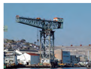
三菱長崎造船所 ジャイアントカンチレバークレーン(長崎市飽の浦町) © 1909年、造船所の工場設備電化に伴い日本に初めて建設されたイギリス製の電動クレーン。
