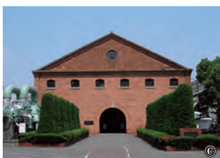
三菱長崎造船所 旧木型場(長崎市飽の浦町) © 1898年、鋳物製造のため、木型を製作する工場として建設。現在は史料館となっている。
