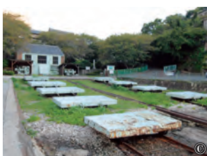
小菅修船場跡(長崎市小菅町) © 1869年、薩摩藩とグラバーによって建設された日本最初の蒸気機関による曳揚げ装置を備えた船の修理施設(スリップドック)。
