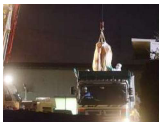
クレーン作業時の安全確認補助（フレコンバックの積み込みはクレーンで実施）
