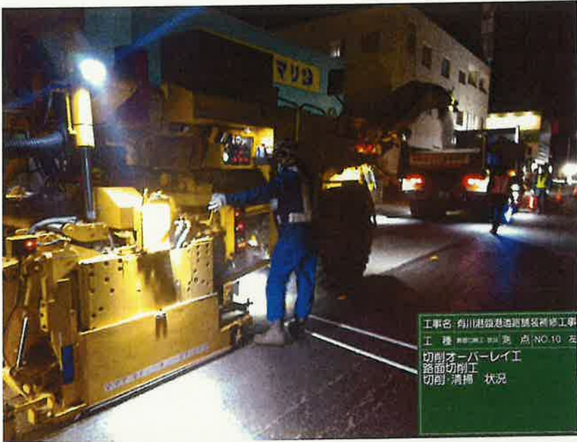
工種：路面切削工：状況 測点：NO.10 左
