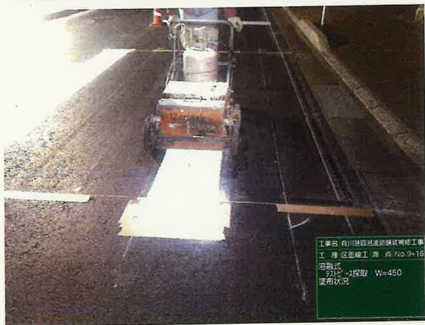
工種：区画線工 測点：No.9+16
