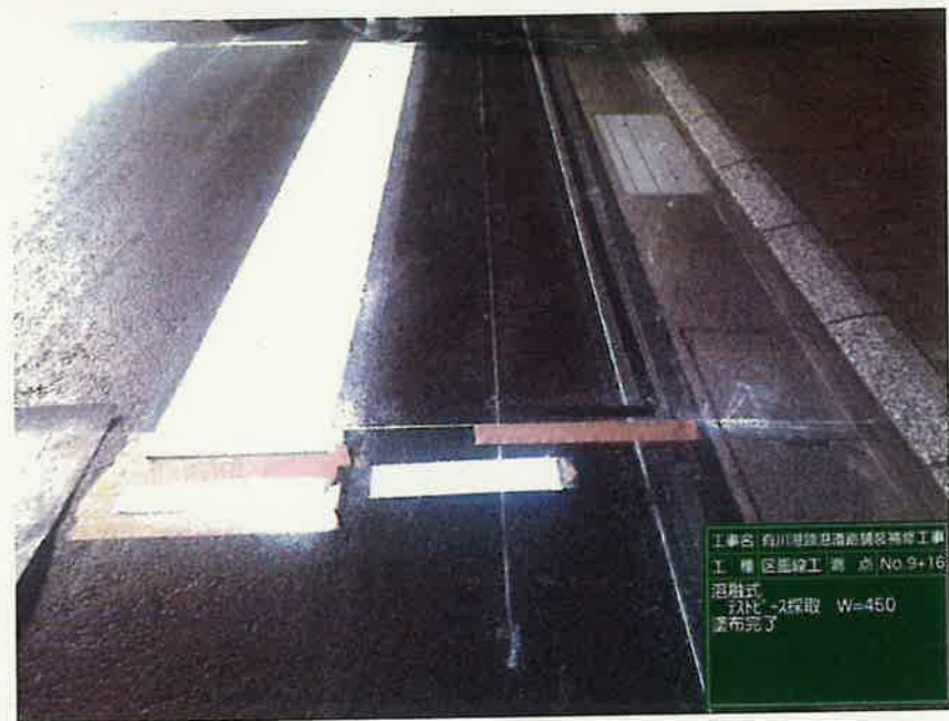
工種：区画線工 測点：No.9+16
