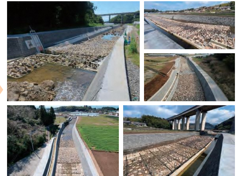
佐奈河内川の改良復旧工事後の状況【大村市】
