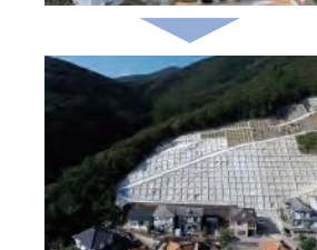
急傾斜地崩壊対策事業【対馬市】
