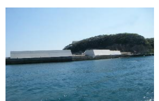
高浜漁港水産生産基盤整備工事
