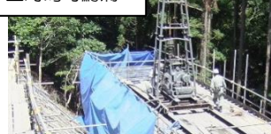
大口径ボーリング工事 -上対馬町鰐浦
