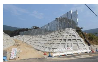
市道内山2号線道路改良工事
