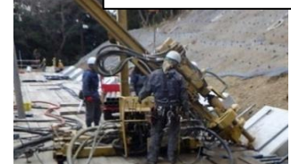
アンカー工事-厳原町久根
