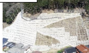
法面工事-峰町三根
