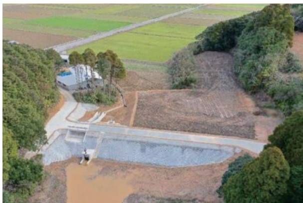
居川ため池完成状況
