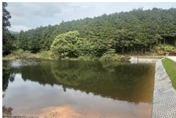
居川ため池内堤側状況
