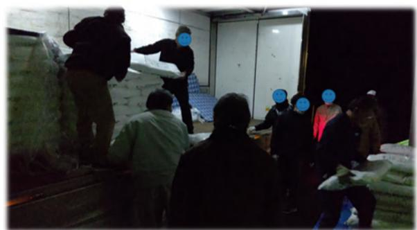
写真-1 資材搬入(消石灰の人力での荷降ろし)
