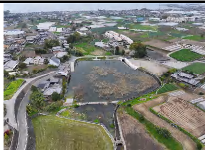
ため池の整備：寺中ため池（島原市）
