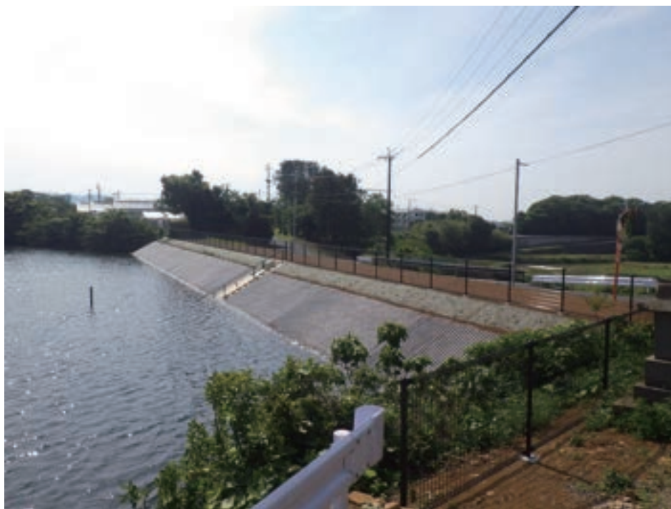
平戸2期地区 鴨山ため池(平戸市)
