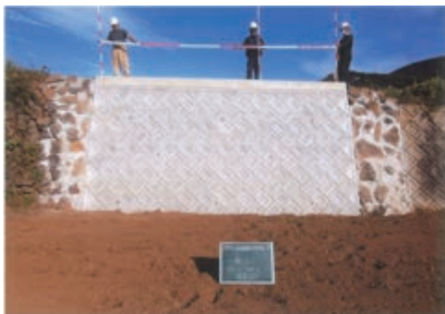
復旧完了(農地) 令和3年度災害(五島市)
