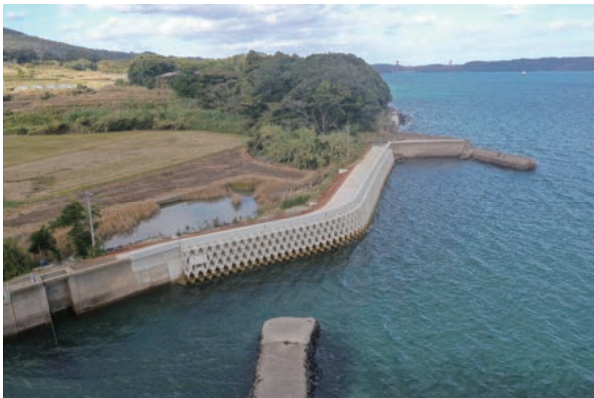
大崎地区 護岸工(平戸市)
