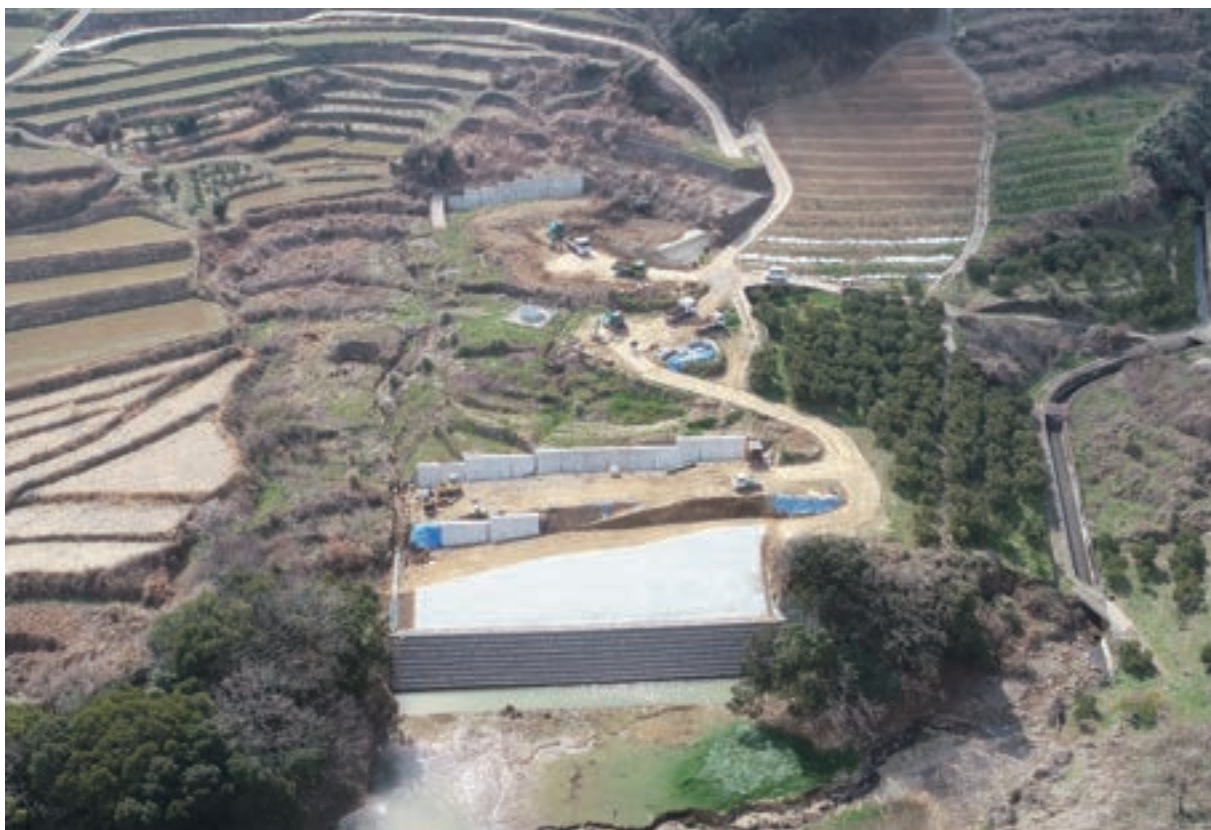
座木地区 抑止工、抑制工(南島原市)
