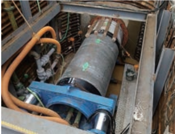
大村北部地区 重井田水路トンネル(大村市) 推進工法
