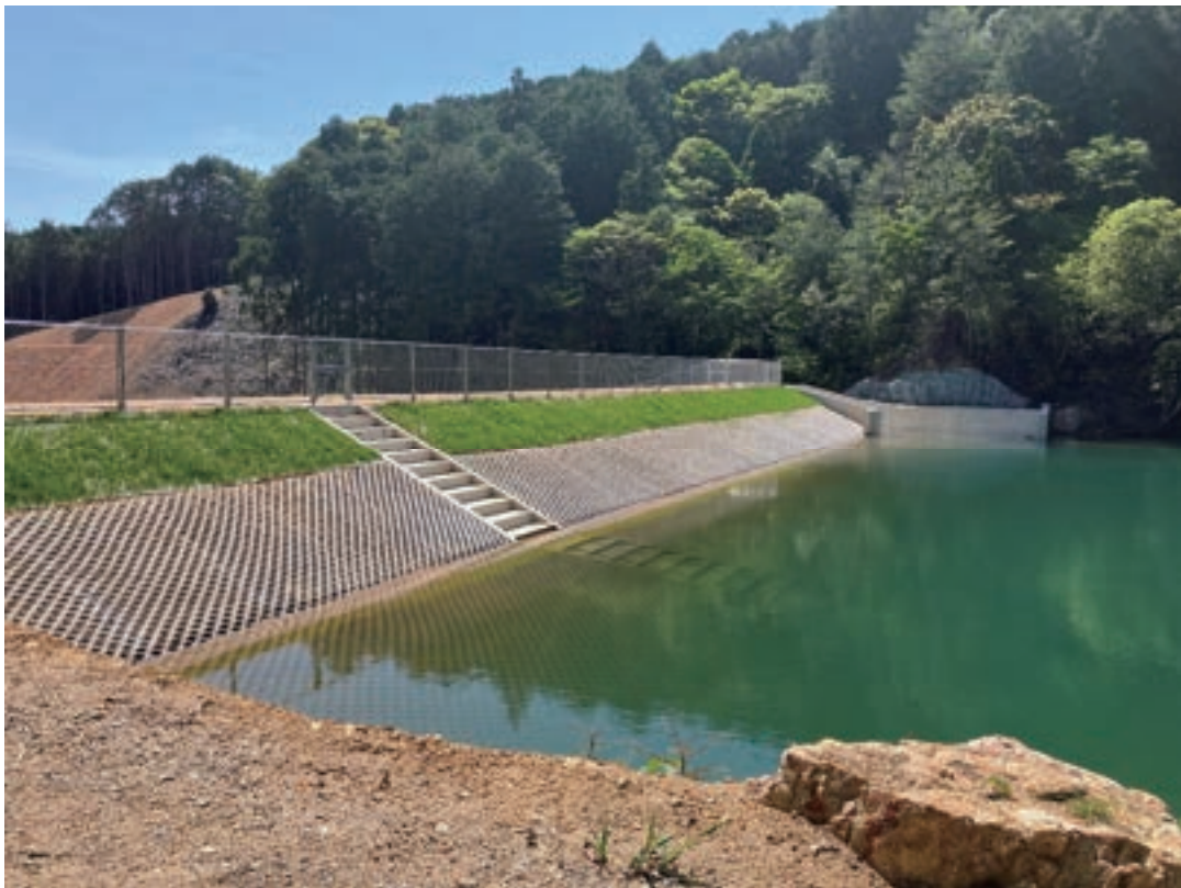
五島地区 津木ため池（五島市）
