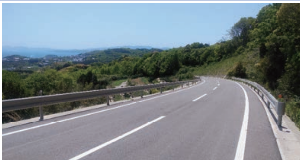
川棚西部地区(H22～実施中)
