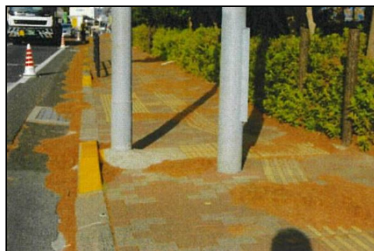
図 6.6 歩道の落葉状況
