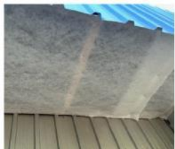
左写真) ウィンドウレス鶏舎 入気口フィルター
