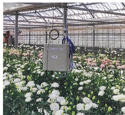
制御機器設置の様子
