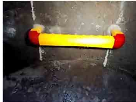
【オンライン検査（足掛金物取付確認）】
