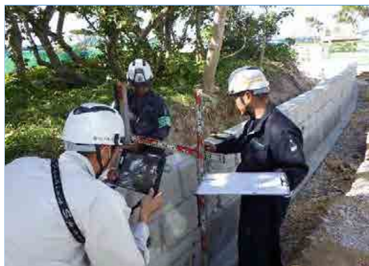
【立会状況（現場側）】
