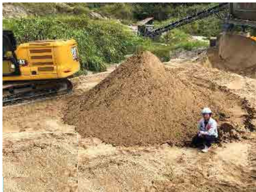
【立会状況（監督側）】
