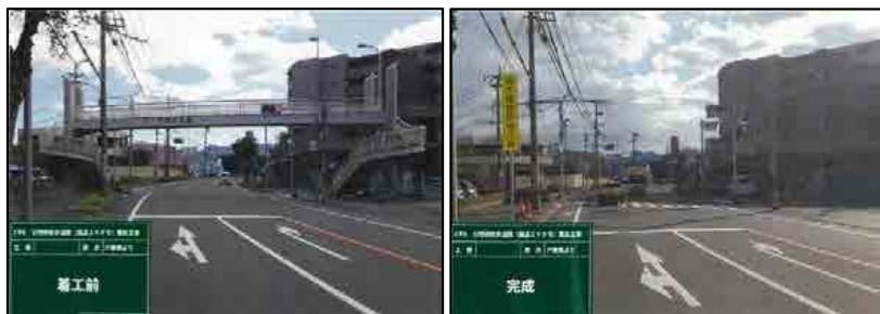
【着工前・完成】
