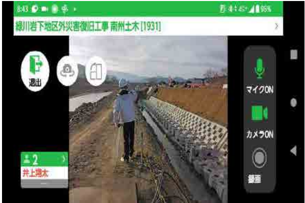
【立会状況（現場側）】
