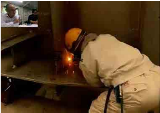
【立会状況（監督側）】
