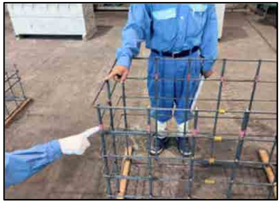
【立会状況（配筋確認）】
