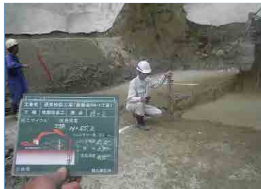
【出来形管理（杭ナビ測量）】
