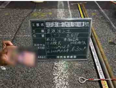
【立会状況（薬液注入ロット検尺）】
