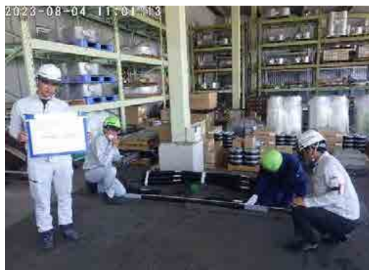
【使用材料確認（遠隔臨場）】
