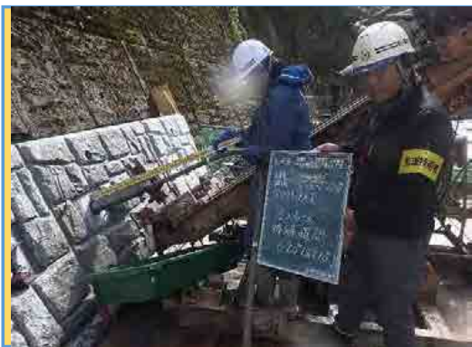
【立会状況(施工状況)】
