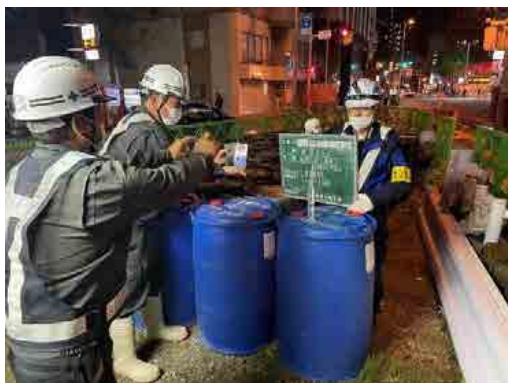
【立会状況（現場側）】
