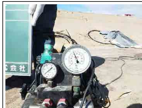
【緊張力を確認（現場側）】
