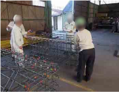
【立会状況（特殊部配筋）】
