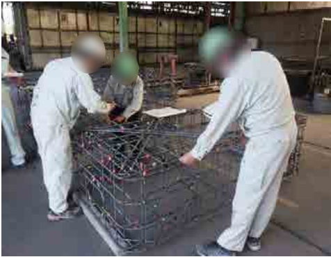
【現地状況（特殊部配筋）】
