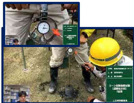
【立会状況（現場側）】
