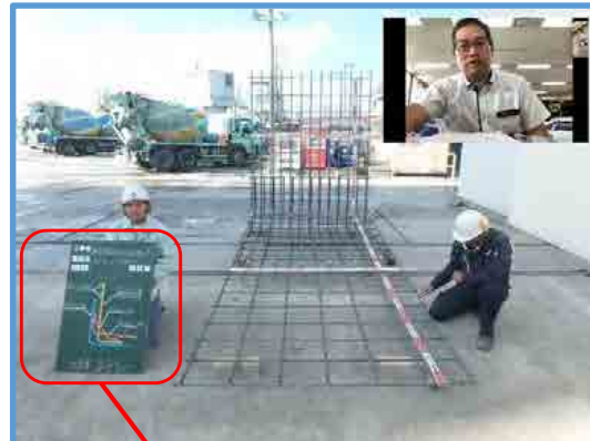
【配筋 立会状況（工場側）】
