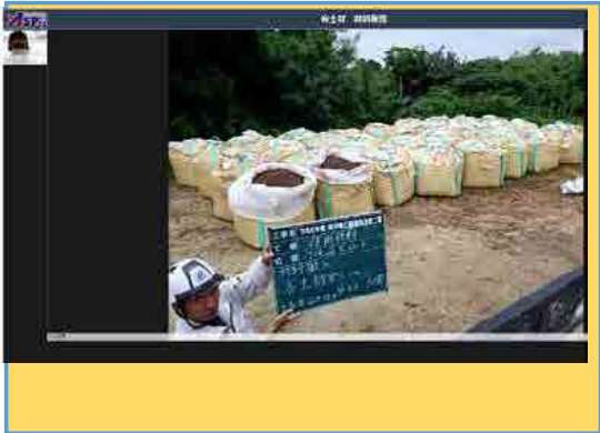
【立会状況（監督側）】
