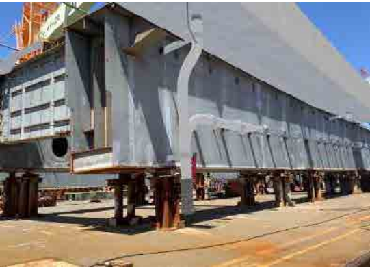
【ARを用いた出来形管理】
