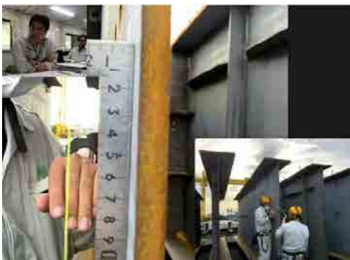
【立会状況（監督側）】
