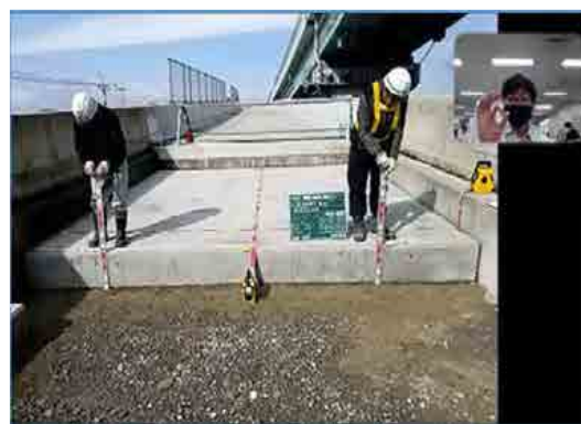
【踏掛版工の出来形検測の様子】
