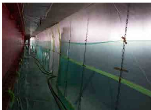
【現場橋梁吊足場内(防犯対策)】
