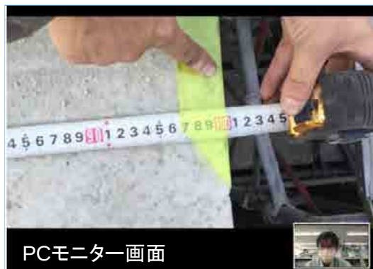
【立会状況（現場側）】
