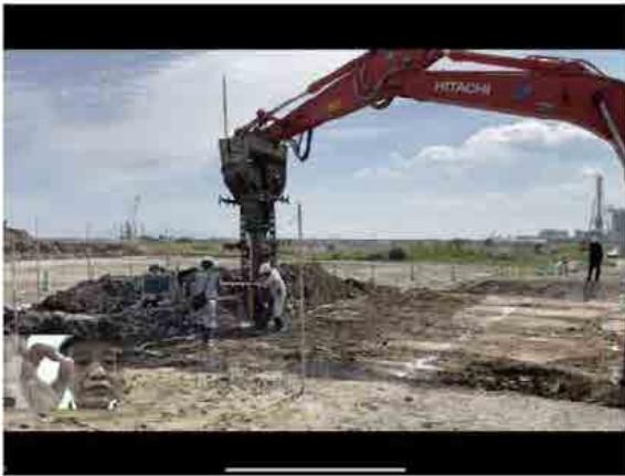
【立会状況（現場側）地盤改良工】
