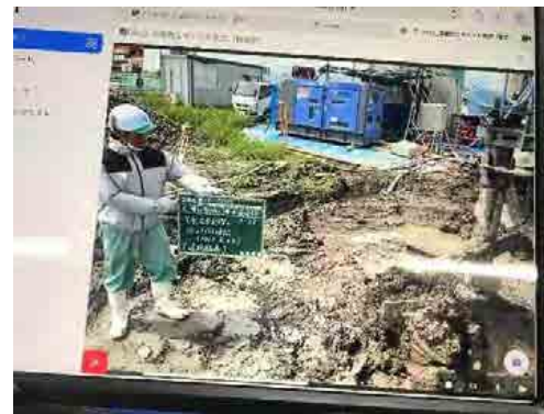
【立会状況（監督側）】
