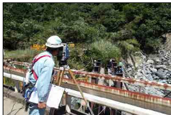
【現場確認状況（支持杭確認）】
