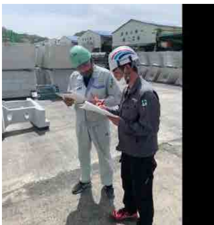
【立会状況（現場側）】
