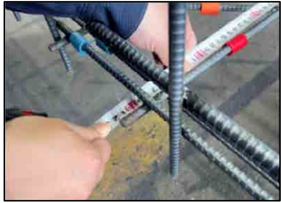
【立会状況（配筋確認；近接）】
