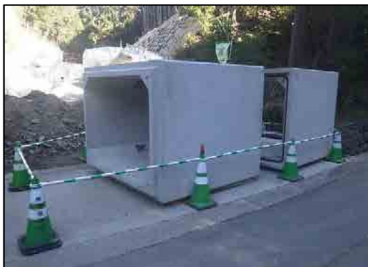
【確認材料（現場側）】
