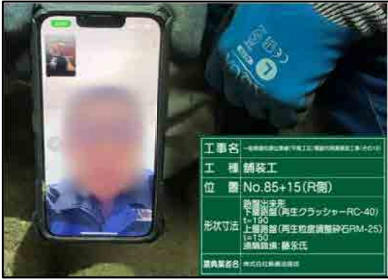
【立会状況（路盤出来形確認）】
