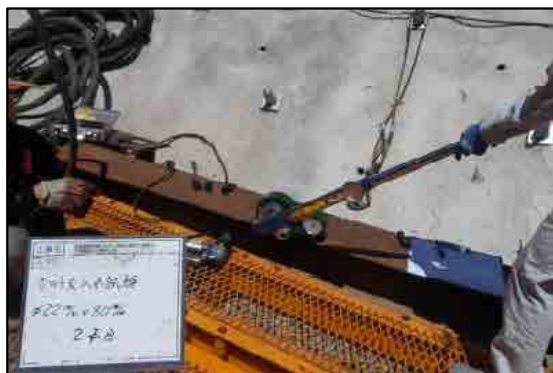
【現場確認状況（トルクレンチ確認）】
