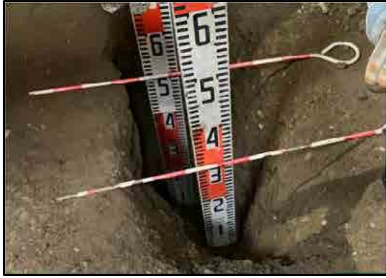
【立会状況（路盤出来形確認）】
