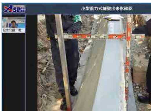
【立会状況（監督側）】
