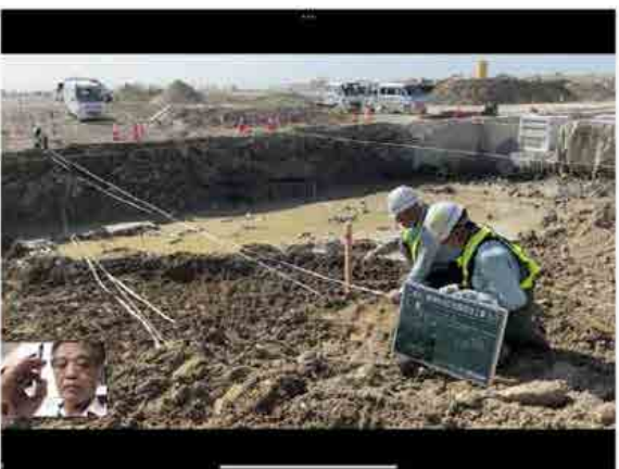
【全体掘削状況】
