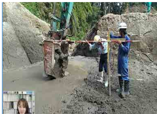
【地盤改良立会状況（現場側）】
