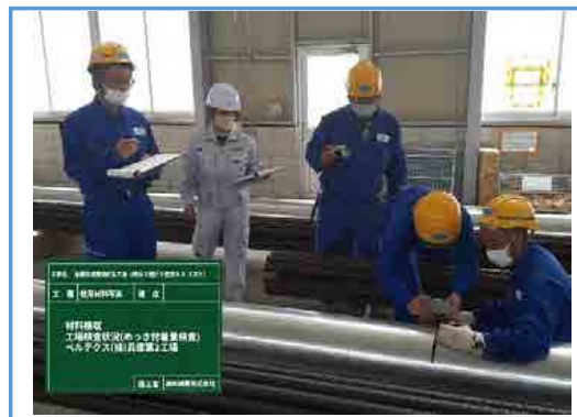
【工夫が分かる写真（全景確認）】
