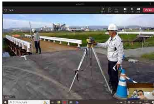
【立会状況(現場側)デジタルレベル】
