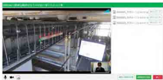
【立会状況（現場側）】
