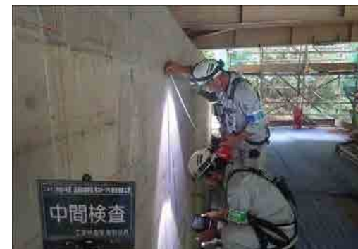
【立会状況（現場側）】
