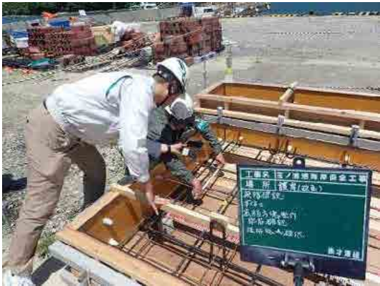
【立会状況（現場側）】
