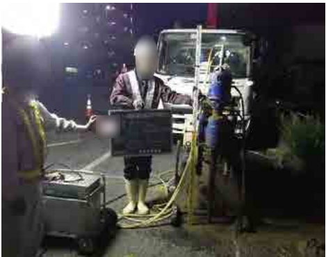
【現地状況（薬液注入ロット検尺）】
