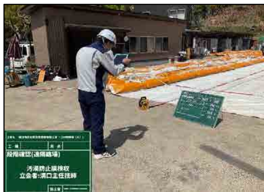
【立会状況（現場側）】
