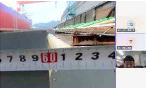
【出来形確認状況（近景）】
