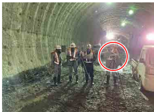
【会議用スピーカーの設置（現場側）】
