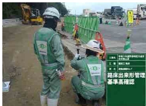
【工夫が分かる写真（杭打ちアプリ）】
