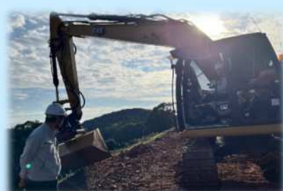
▲ICT土工(盛土)建機の体験
