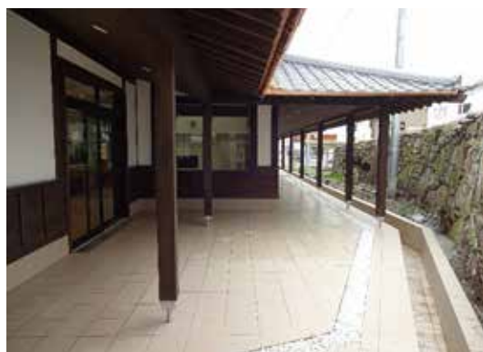
敷地内の古い石塀と下屋空間
