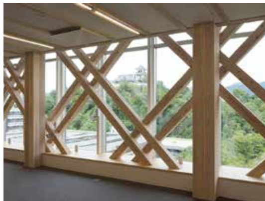
木製ブレース 窓側
