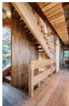
杉 CLT のみで構成された階段
