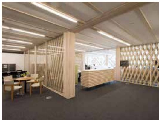
木製ブレース 室内側
