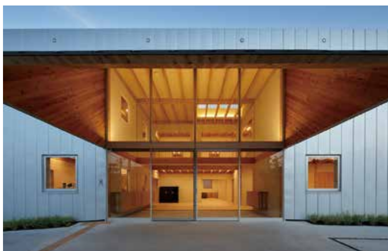
エントランス外観
