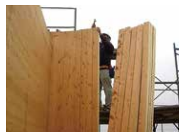
図 3. 側板を建て込む様子
