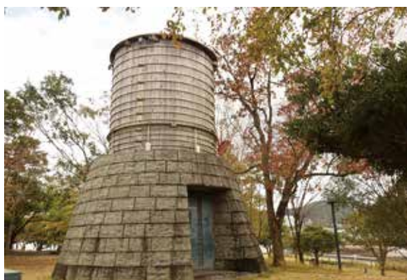
受水槽全体の外観
