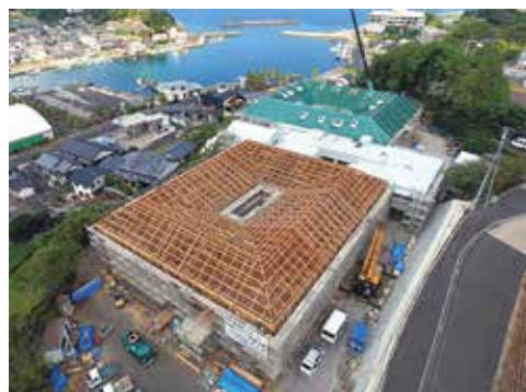
木造東棟の小屋組施工写真
