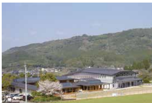
外観（校舎棟+体育館）
