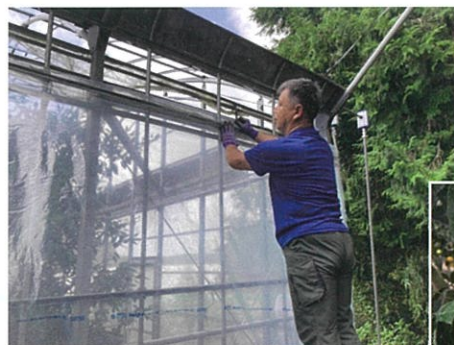
ハウスビニールの張り替え作業
