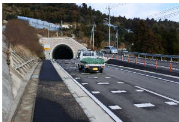
平成29年2月に供用開始した茂木工区
