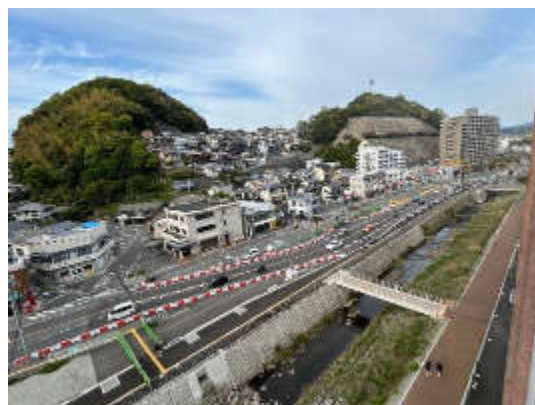
大神宮工区の施工状況
